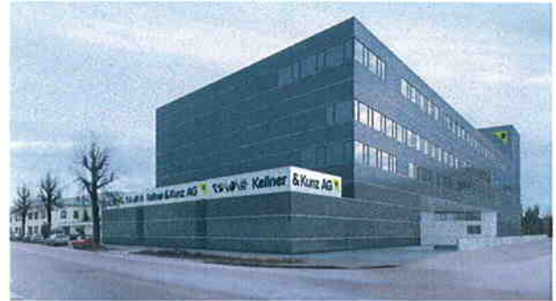
Welscher Logistikzentrum nach Fertigstellung im Herbst 2009.
